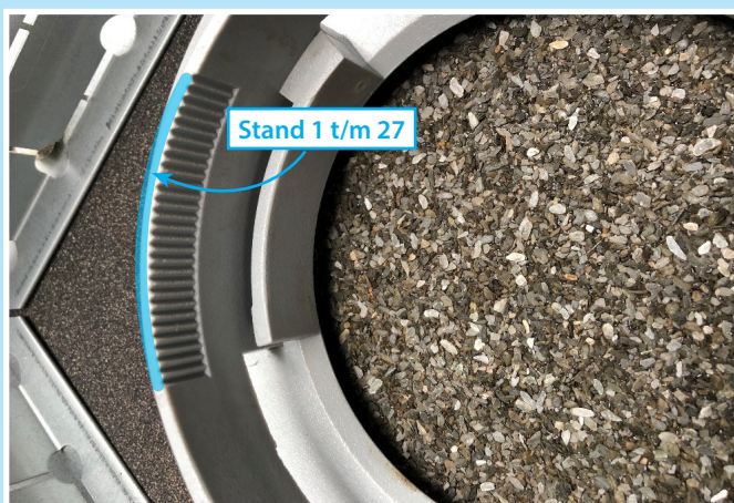
Afbeelding 11. Binnenaanzicht van ring B zonder bevestiging van de stuwring
