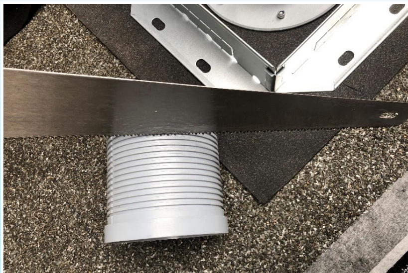
Afbeelding 14. Noodoverloop op maat maken
