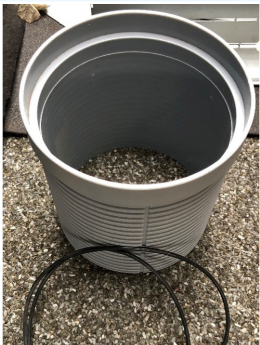
Afbeelding 13. Noodoverloop nadat de twee afdichtingsringen zijn afgenomen
