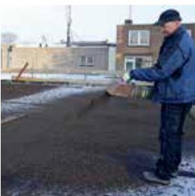
Geblasen (Silo Lkw)
